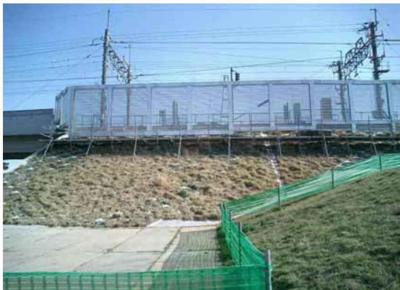
JR東北本線 栗橋・古河間 防風柵(利根川橋梁)
