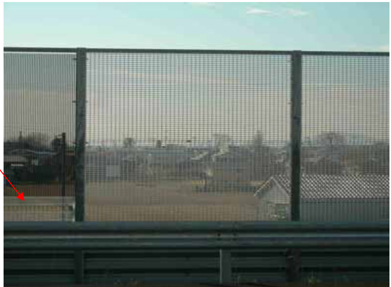
有孔折板(補強用) (開口率 = 40%)
