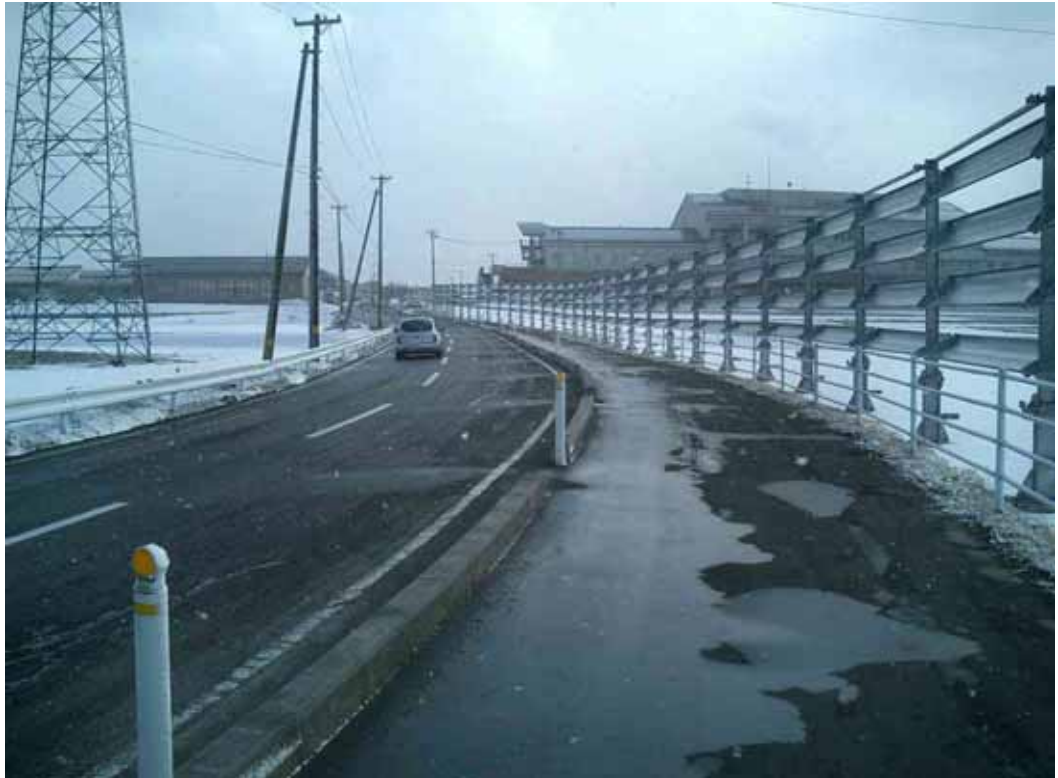
エアロフェンス設置箇所は除雪の跡が無く、綺麗に吹払われています
