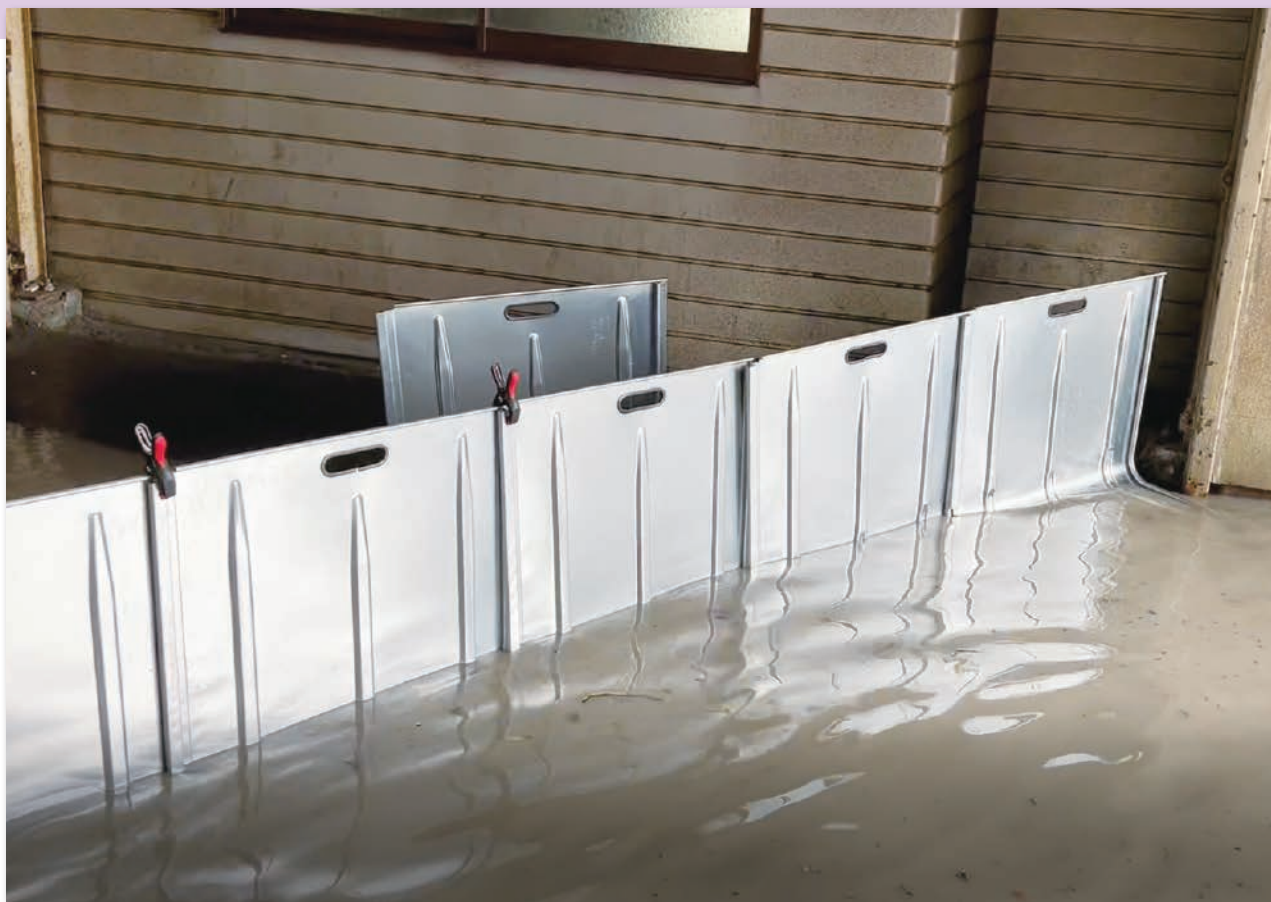
豪雨発生時に設置
