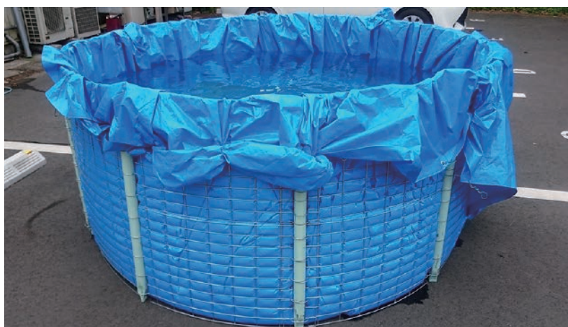
5.水を貯めて簡易水槽完成
