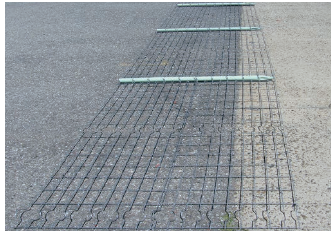
2.ジョイント部に支柱を挿入しメッシュパネル全体一体化
