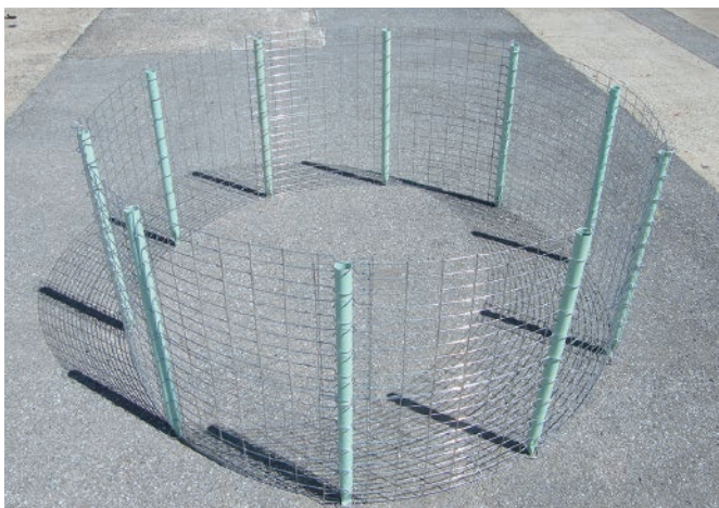
3.メッシュパネルを起こして円形状に曲げ、端部ジョイント部と中間部に支柱を設置
